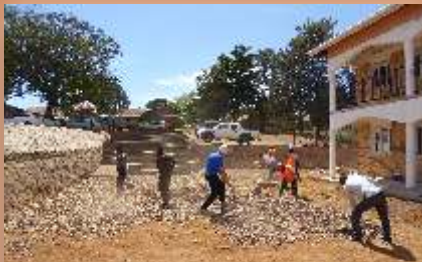
...der Schulhof wird gepflastert
